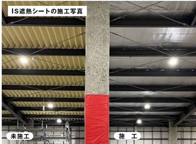
同構造の倉庫2階にて、IS遮熱シートの未施工・施工で分け、それぞれの地上約1.5mの箇所に、温度計を設置、12時～13時の間で日中温度推移を計測。
